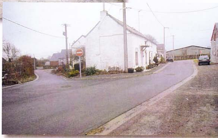
Après les travaux
