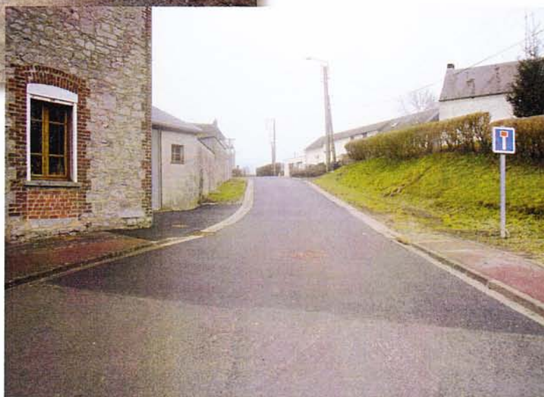
Après les travaux
