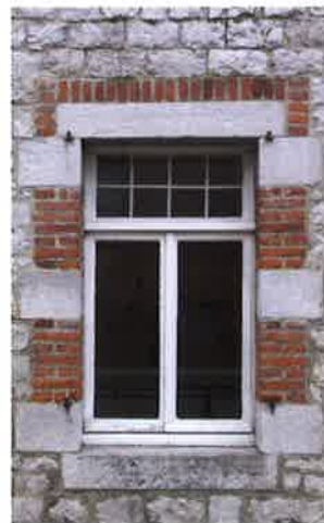
Linteau droit surmonté d'un rang de brique, première moitié du XIX e siècle.
