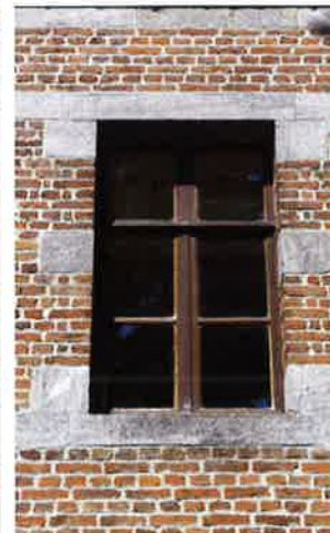
Linteau droit prolongé par des bandeaux en calcaire, milieu du XIX e siècle.
