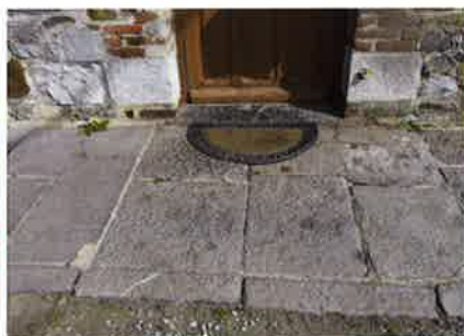
Trottoir en dalle de calcaire.
