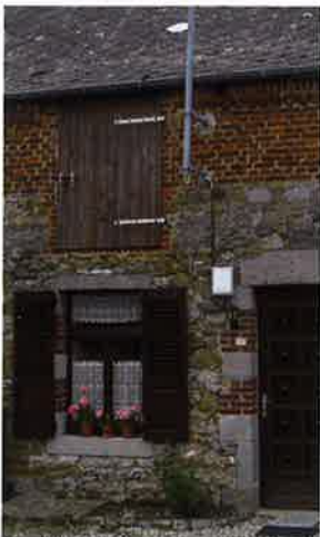
Surélévation en brique sur un rez-de-chaussée en maçonnerie composite.
