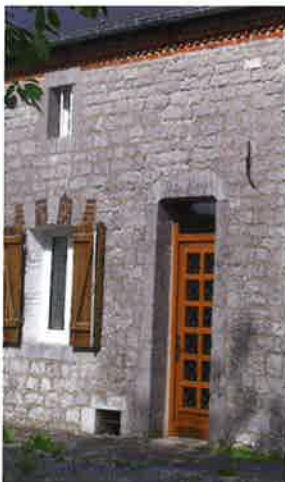
Maçonnerie de moellons de calcaire (pierre bleue).
