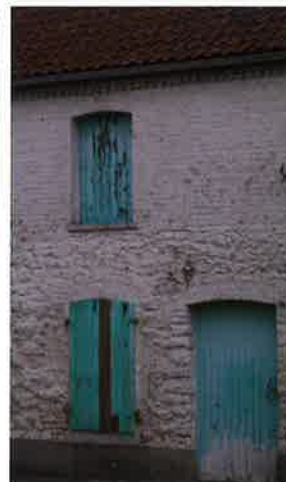
Maçonnerie de moellons de calcaire et de brique chaulée.
