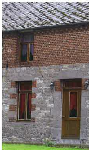
Surélévation en brique sur un rez-de-chaussée en calcaire.
