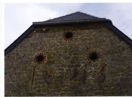
Chronogramme en brique dans un pignon en moellons de calcaire.
