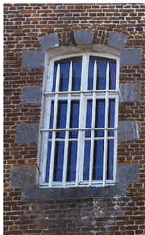
Linteau cintré alternant brique et dés de calcaire, seconde moitié du XVIII e siècle.
