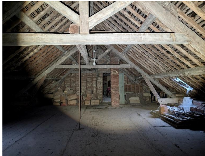
Figure 26 : Grenier de la mairie
